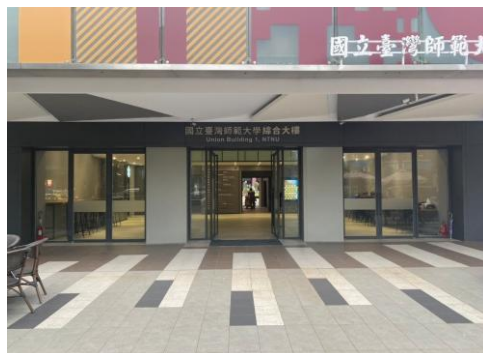
綜合大樓 1 樓門面改善(一)
